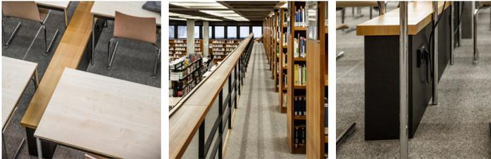
Zu den durchgeführten Arbeiten gehören insbesondere die komplette Erneuerung des Teppichs und die Erneuerung des Deckenanstrichs. Darüber hinaus wurden umfangreiche Elektrifizierungsmaßnahmen durchgeführt, in diesem Zuge wurden u. a. an zahlreichen Stellen neue Steckdosen installiert. Weiterhin wurden Elektrokonsolen in die Innenbereiche der Lesesaalteile West und Ost eingebaut bzw. verlängert, um auch eine Stromversorgung der innenliegenden Arbeitsplätze zu ermöglichen.
